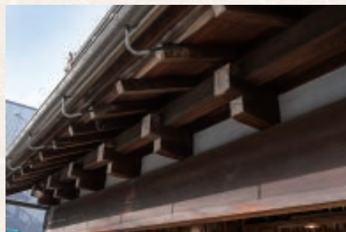
軒下に桁が張り出しています。その下の重厚な差し鴨居と呼ばれる部分は、建物の荷重を支えるとともに商家の格式を示すものでもありました
