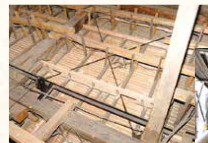
ホール天井内部
